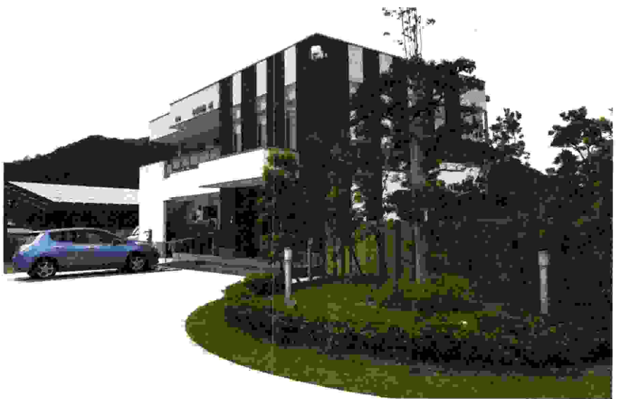
「SAVeR-H」を活用した自家消費を検証するデルタ電子の実験施設
