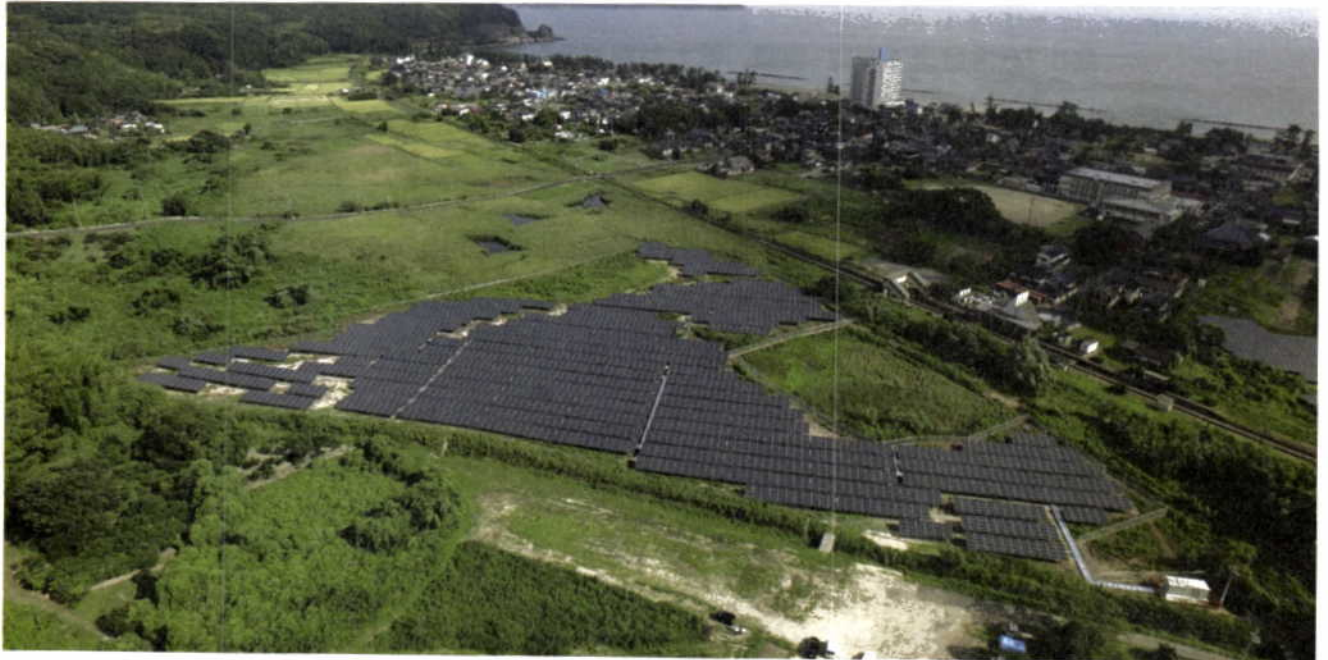
由良第一太陽光発電所(京都府宮津市)。 獣害の被害も見受けられる地域だったが太陽光発電設置で解消した(写真はOFEのHPより)
