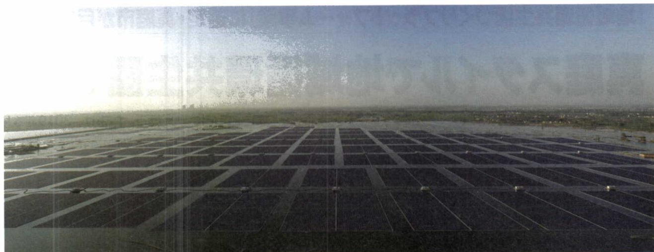
中国安徽省穎上の130MWの水上メガソーラー。4,700ha以上の水域に40万枚以上のモジュールを設置(写真上)。 両面ガラスモジュール「DUOMAX」と、裏面からの発電も合わせてより大きな 発電量が見込める両面発電シリーズ「DUOMAX Twin」(写真下)
